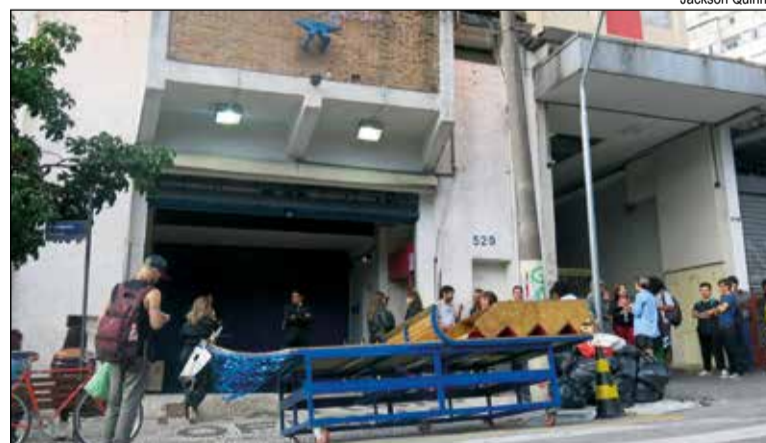
Fachada do Teatro Oficina Uzyna Uzona, no centro de São Paulo
