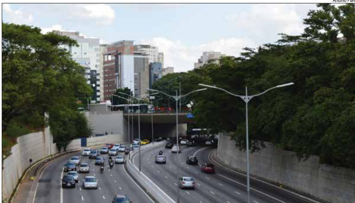
Vista do viaduto na Avenida 23 de maio
